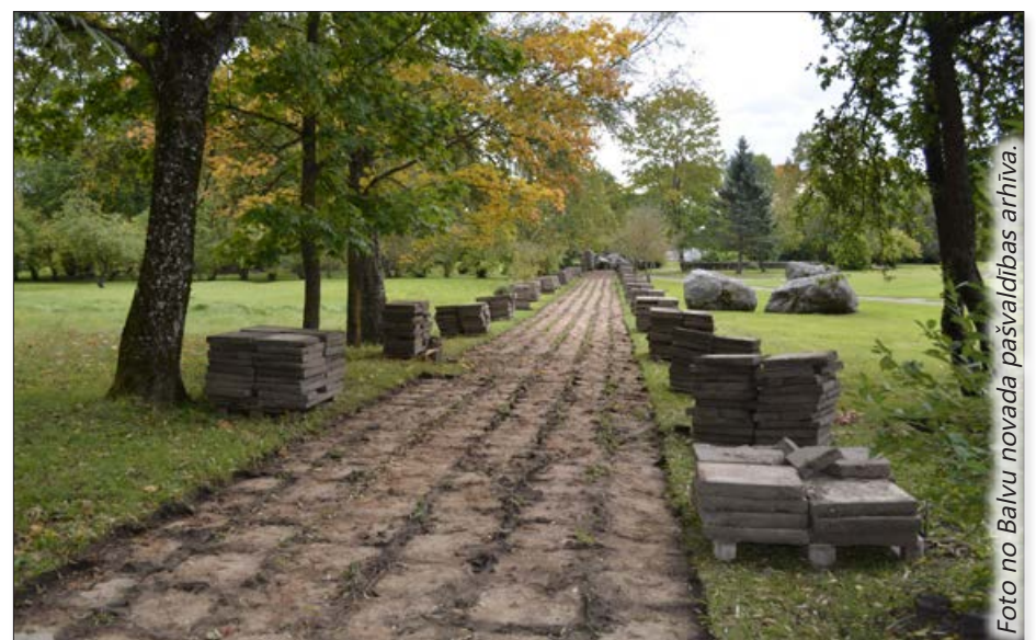
Lāča dārzā sākušies demontāžas darbi - tiek novākti betona fližu celiņi.
