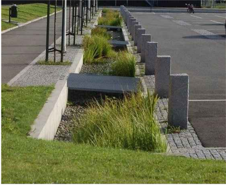
Lietusūdens savākšanas un attīrīšanas risinājumi joslās starp barucamo daļu vai auto stāvlaukumu un gājēju ietvi. Padziļināta tekne ar betonētām malām un infiltrējošu gultni. Gultnē stādīti fitoremediācijas jeb augsni attīroši augi. Vides pieejamībai izbūvētas laipas.
