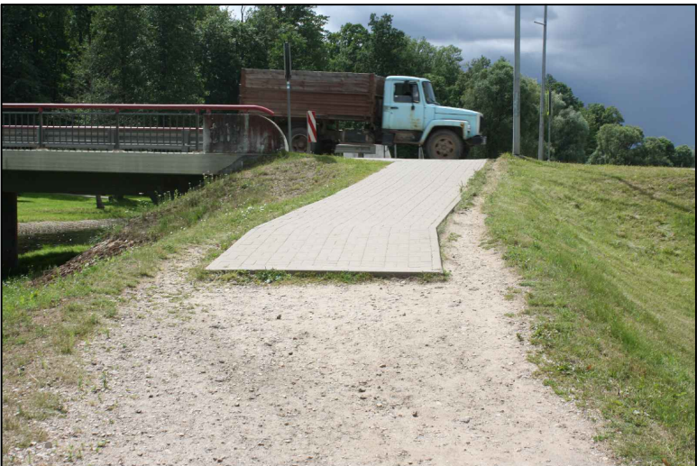
8 Betona bruģakmens seguma celiņš
