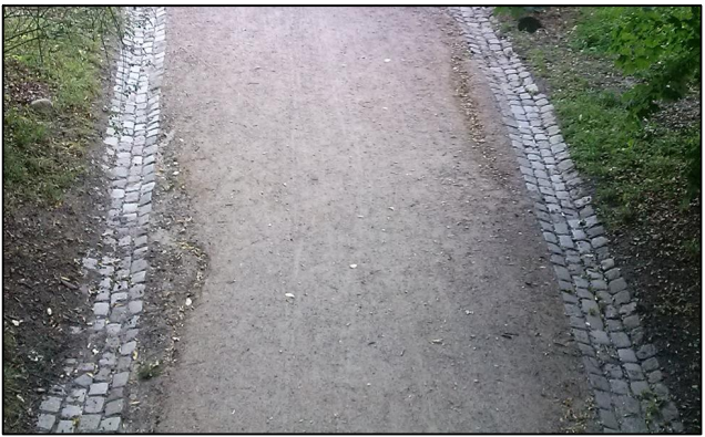
Grants takas pasargāšanai no izskalojumiem, piemērs
