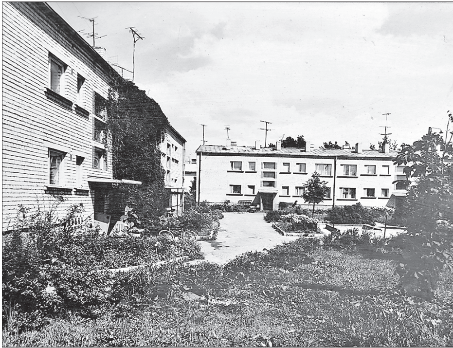
Daudzdzīvokļu māja Liepnas ielā 10 un Sporta ielā 2
