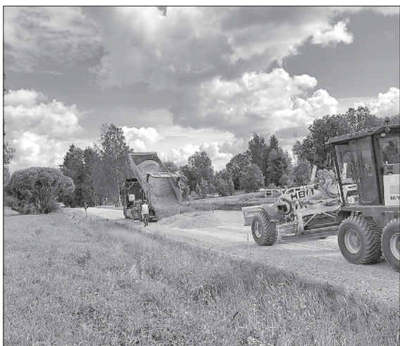
Dīķa ielas remontdarbi Šķilbanos
