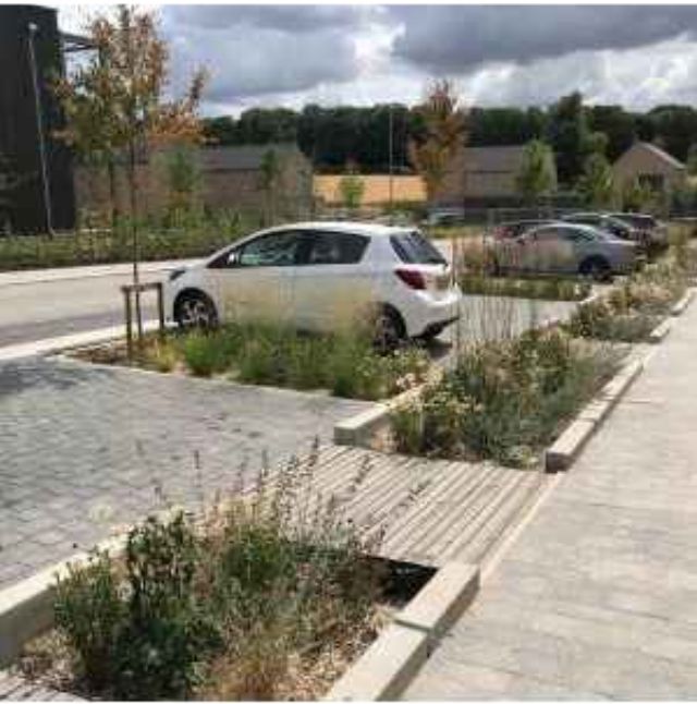
Lietusūdens savākšanas un attīrīšanas risinājumi joslās starp barucamo daļu vai auto stāvlaukumu un gājēju ietvi. Padziļināta tekne ar betonētām malām un infiltrējošu gultni. Gultnē stādīti fitoremediācijas jeb augsni attīroši augi. Vides pieejamībai izbūvētas laipas.
