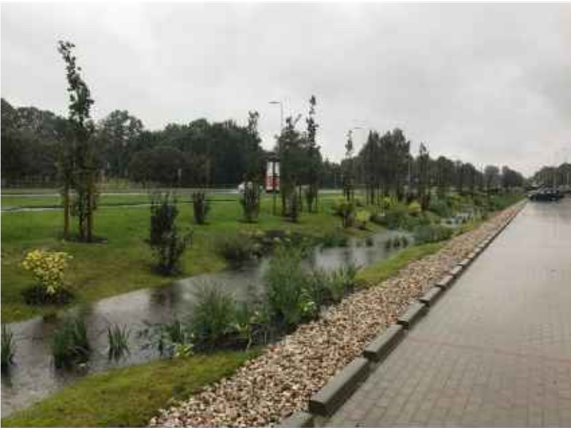
Auto stāvlaukuma lietusūdens risinājumu sistēma. Avots: Ilgspējīgo lietusūdeņu apsaimniekošanas risinājumu izmantošanas projektēšanas vadlīnijas, 2021
