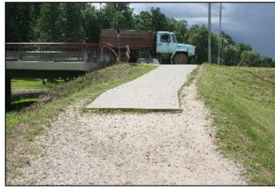
8 Betona bruģakmens seguma celiņš
