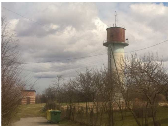
30. attēls "Rugāju Ciema ūdenstornis" (foto 14.04.17.)
