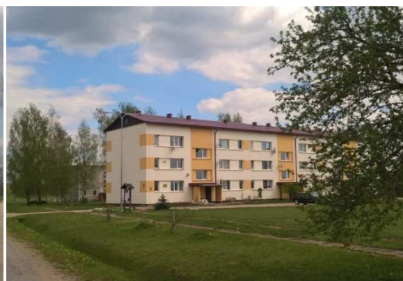
12. attēls "Skats uz renovēto mazstāvu dzīvojamo apbūvi Skujetniekos" (foto 19.05.17.)
