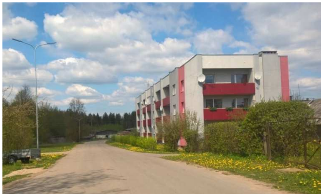
8. attēls "Renovētā mazstāvu dzīvojamā apbūve Skolas ielā" (foto 19.05.17.)
