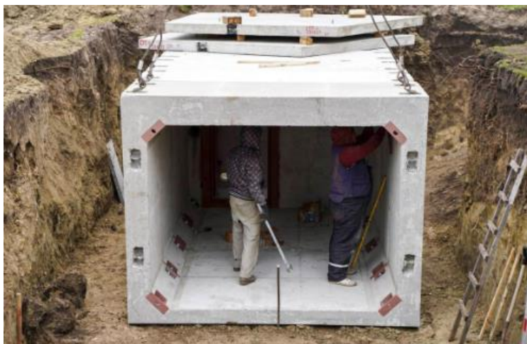
Attēls. Dzelzsbetona bloku konstrukcijas 7
