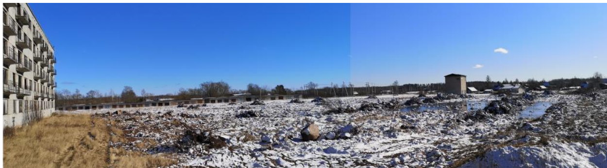
10. attēls. Skats uz lokālpilānojuma teritorijā esošo dzīvojamo apbūvi no Ezera ielas. Fotogrāfijas avots: SIA „PLĀNS & BŪVE”.
